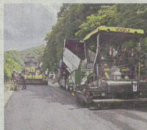
大きな重機を使って進められる道路のアスファルト舗装工事
